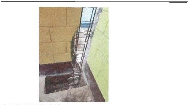
Foto 2: Paredes grietadas por sismos de preprimaria son reforzadas por columnas
